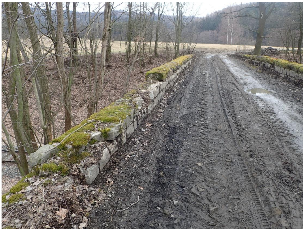
Foto 3: Zborcená horní řada kamenů tvořící římsu, objekt bez zábradlí
