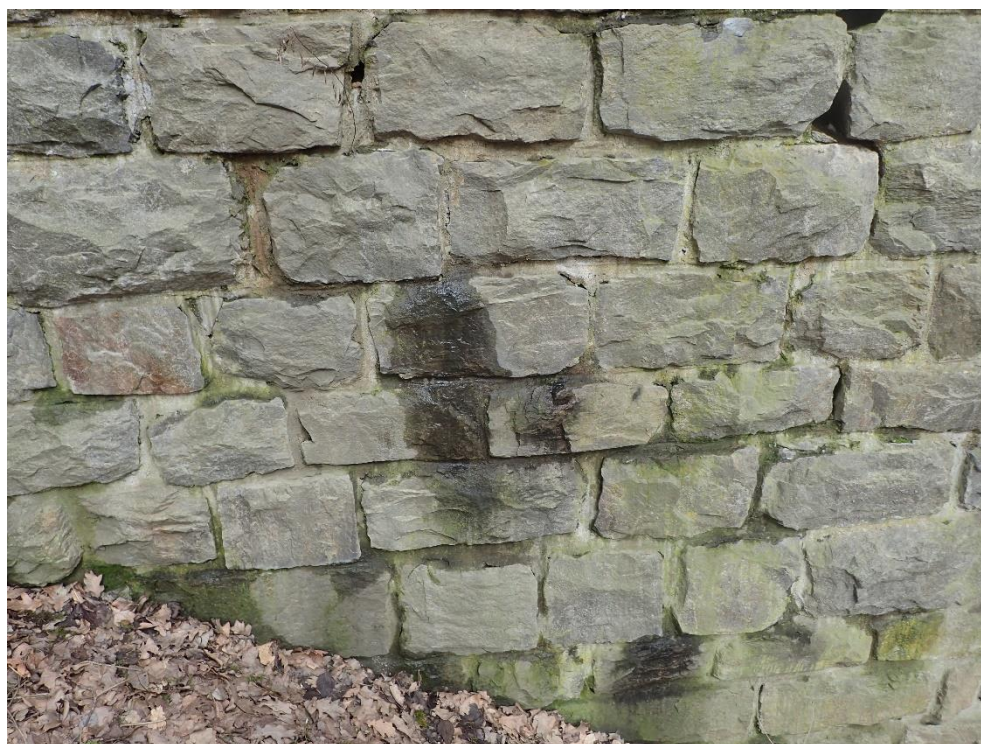
Foto 4: Průsaky přes zdivo
