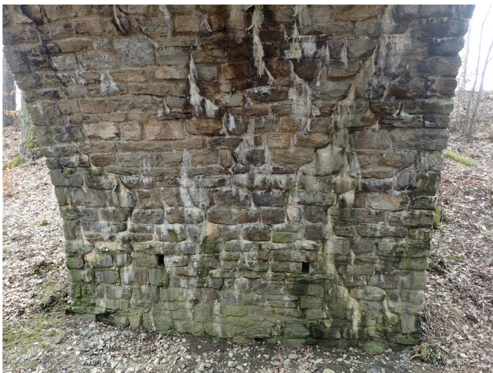
Foto 2: Průsaky přes zdivo, známky po zatékání a výkvěty
